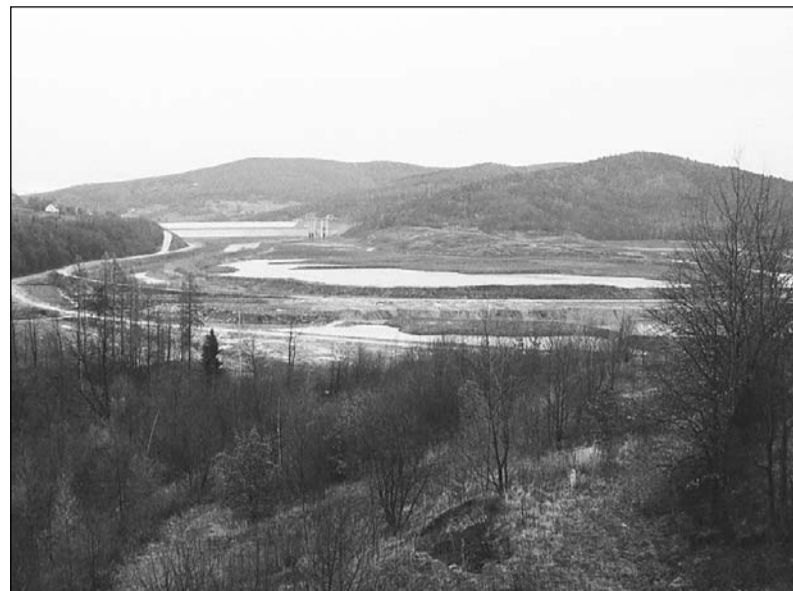
Budowa zapory wodnej na Skawie w Beskidzie Małym
