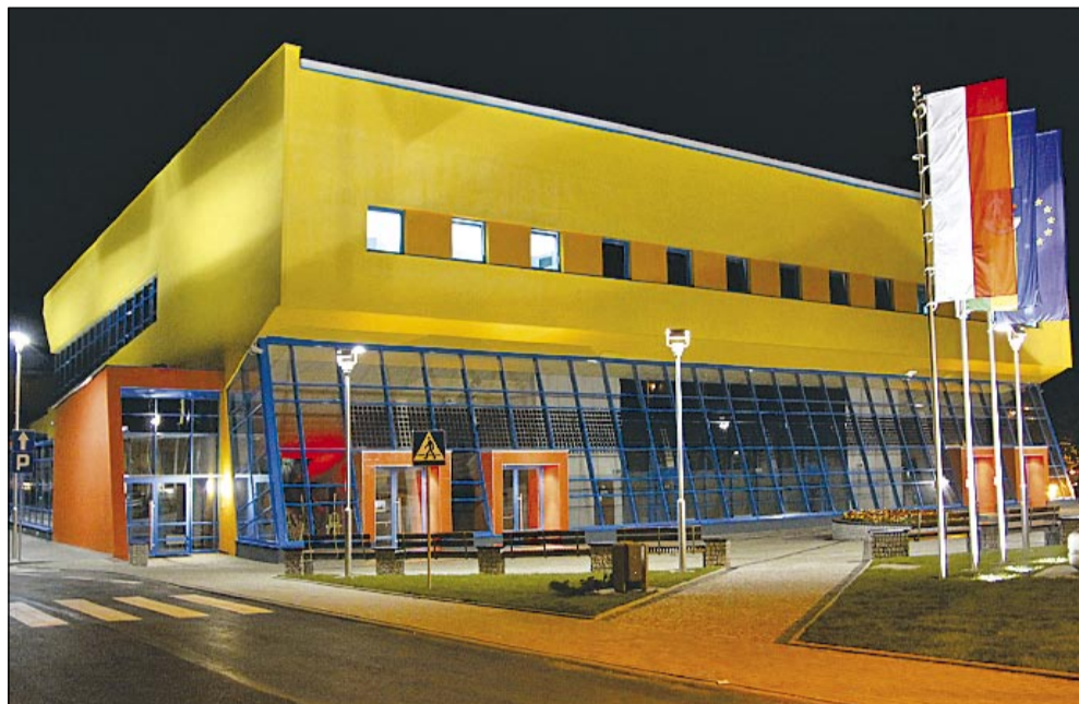
Ogniwa fotowoltaiczne, jakie zainstalowano na przedniej elewacji Hali Kompleksu Sportowego „Michał” w Siemianowicach Śląskich, przetwarzają energię słoneczną na elektryczną
