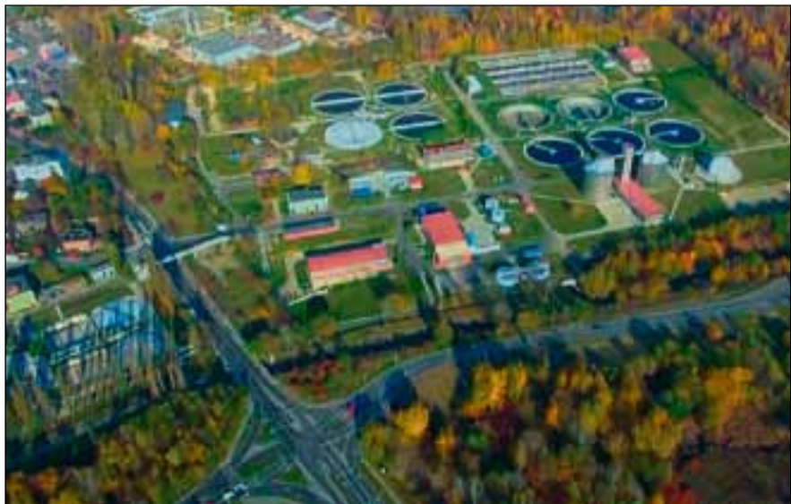
Oczyszczalnia ścieków „Klimzowiec” po modernizacji - październik 2011 r.
